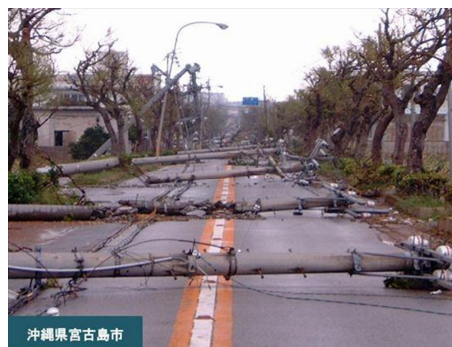
台風で倒壊した電柱が完全に道路を塞いでいる様子
